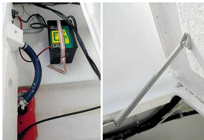
Die Batteriekabel sollten sorgfältiger verlegt werden. Der Federaufsteller am Staufachdeckel ist ebenfalls keine Ideallösung
